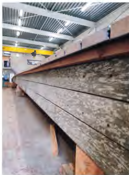
Hergebruikte liggers en damwanden in de 'nieuwe' brug.
