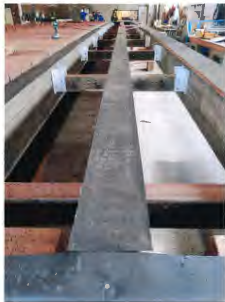
Constructie met EPDM-bescherming.
