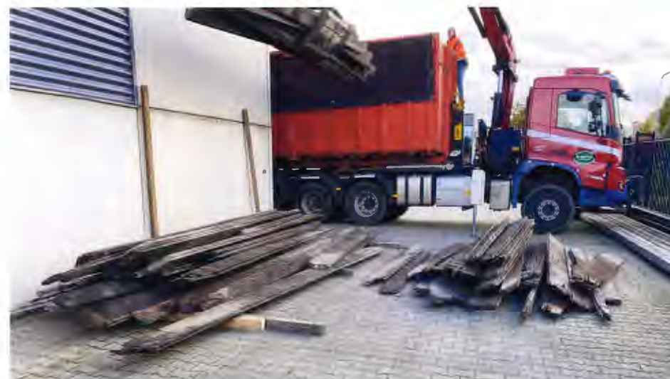
De oogst van de damwand. (Beeld: Provincie Gelderland)
