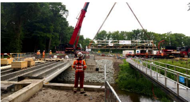
▲ Voor de bouw van de Vloedstegenbrug zijn, na modificatie, bestaande liggers hergebruikt.
