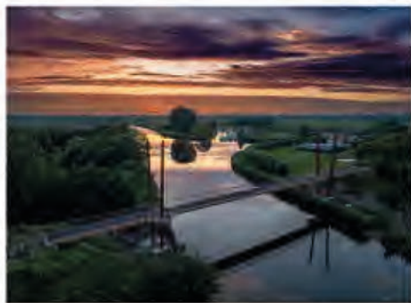
De fiets- en voetgangersbrug is 92 m lang.
